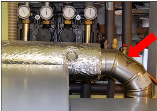
Öffnen Sie am Abgasrohr die Revisionsöffnungen um das Abgasrohr vom Kessel in Richtung Schornstein zu reinigen. Wir empfehlen diese Arbeiten durch den Schornsteinfeger durchführen zu lassen.
