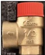
Bitte unterziehen Sie alle vorhandenen Sicherheitsventile der Heizungsanlage (z.B. Kessel, Puffer, Solar, Trinkwasser) einer Sichtprüfung. Die Abläufe der Ventile dürfen nicht tropfen. Sollte eines der Ventile tropfen, dann drehen Sie das Ventil mit einer viertel Umdrehung an der roten bzw. blauen Kappe auf, um dieses kurz auszuspülen. Sollte das Sicherheitsventil trotz mehrmaliger Spülung nicht mehr dicht schließen, dann muss dieses umgehend gereinigt oder ausgetauscht werden!
