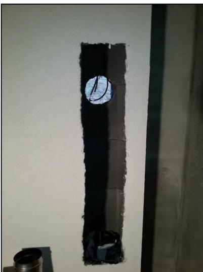
Abb. 51: Schornsteinschacht wie dargestellt öffnen. Dieser bestimmt die Position des Zugreglers sowie der unteren Reinigungsöffnung. **Bitte sprechen Sie mit Ihrem Bezirksschornsteinfeger über die beste geeignete Position.**
