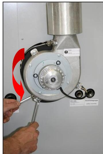
Abb. 25 Montieren Sie nun das Saugzuggebläse, indem Sie die alte weiße Dichtung vom Gehäuse entfernen und durch die beigelegte rote Dichtung (ohne Löcher) ersetzen. Befestigen Sie das Gebläsegehäuse mit den drei beigelegten Schrauben am Drehflansch des Kessels. Sie können den Rauchgasabgang in die gewünschte Position drehen (links max. 85°, rechts max. 65°). Die Standardposition ist senkrecht nach oben. Siehe Hinweis Abb. 67.
