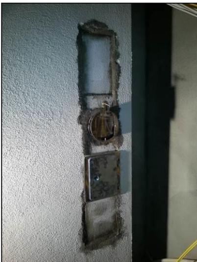
Abb. 55: Prüfen Sie nochmals alle Verbindungen und setzen Sie anschließend den Kaminzugregler sowie das Putztürchen in das Mauerwerk ein. Mauern Sie die Hohlräume dazwischen vollständig aus. Sprechen Sie über die Auswahl des richtigen Mauermaterials mit Ihrem zuständigen Schornsteinfeger.
