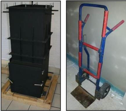
Abb. 19: Nun kann der Kessel mit einem geeigneten stabilen „Sackkarren“ oder Treppensteiger mit ca. 3 Personen zum Heizraum transportiert werden. Heben Sie diesen dazu von der Transportpalette.
