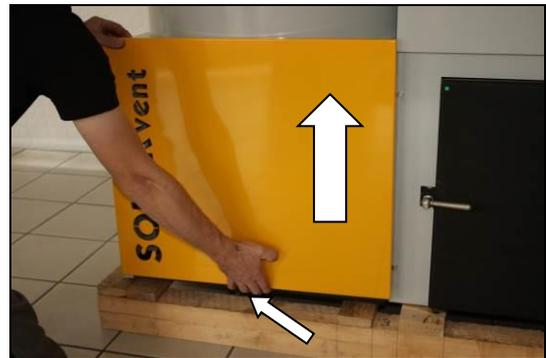
Abb. 6: Sicherungsschraube (unten) entfernen und Verkleidung ca. 1 cm nach oben schieben und dann nach vorne abnehmen.
