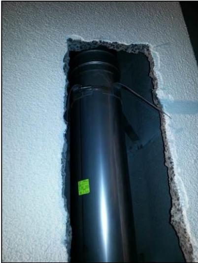
Abb. 54: Nach spätestens 3 Längenelemente a 1 m ist eine Montageschelle zur Fixierung im Schacht anzubringen.
