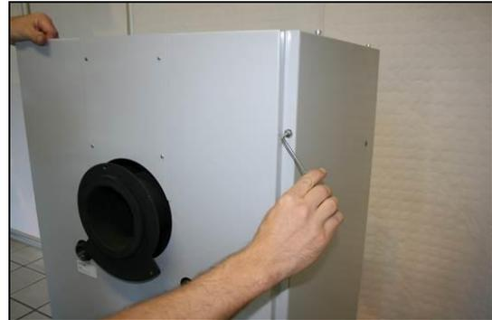
Abb. 24 Nun das rückseitige Blech wieder am Kessel montieren, indem Sie dieses mit 8 Inbusschrauben befestigen. Wenn das Blech richtig montiert ist, muss der obere Rand mit dem linken und dem rechten Seitenteil bündig sein.
