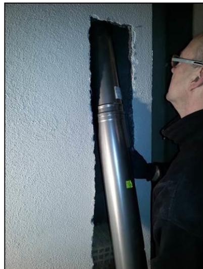
Abb. 53: Bis zu einer Schornsteinhöhe von ca. 7 m kann man die Schornsteinelemente von unten nach oben schieben. Bei größeren Höhen empfiehlt es sich, die Elemente mit Hilfe eines Ablassseils vom Kopfende nach unten herabzulassen. Hierfür ist ein stabiles Seil an das im Grundpaket mitgelieferte „Längenelement mit Ablassschlaufe“ zu befestigen.
