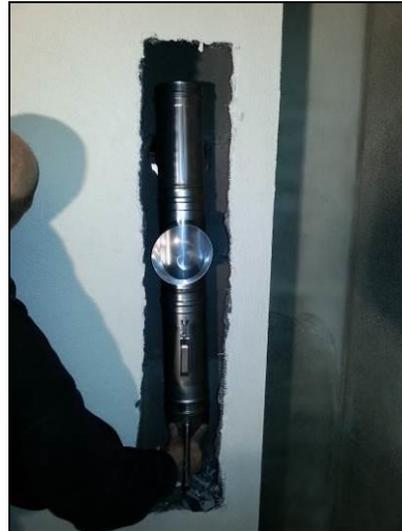
Abb. 52: Stecken Sie die Kondensatschale, das Reinigungselement, den 130-er T-Zugregleranschluss für den Zugregler, den 130-er T-Kesselanschluss zusammen und prüfen Sie den korrekten Sitz im Schornsteinschacht. Unter der Kondensatschale ist ein tragfähiger Sockel zu mauern, auf welchem sich die Schornsteinelemente abstützen können.
