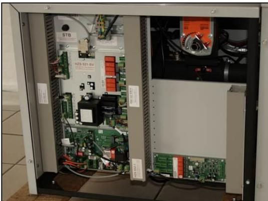
Abb. 34: Hier befinden sich die Steuerplatinen. Der linke Teil umfasst den Standardlieferumfang, der rechte Teil die individuell bestellten Erweiterungsplatinen SVHZS532-1, 53x. Im mittleren Kabelkanal werden die 230 V Kabel verlegt, in den beiden äußeren Kabelkanälen die Schwachstromkabel (Belimo, Fühler, Sensoren, Lambdasonde).
