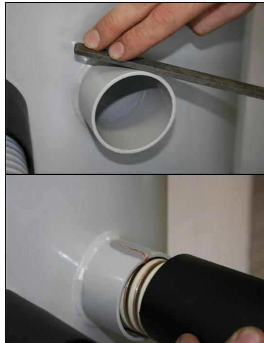
Abb. 47: Mit einer Feile die Grundierung wie dargestellt entfernen, damit der Pellets-Saugschlauch an dieser Stelle geerdet werden kann. Ca. 10 cm Kupferlitze vom Pelletschlauch abziehen und wie dargestellt auf die metallisch blanke Stelle am Stutzen legen.
