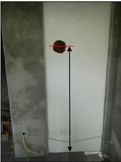
Abb. 50: Ermittlung der korrekten Höhe des Rauchrohreintritts in den Schornstein. Diese ist abhängig von der Aufstell-position der Pelletheizung zum Schornstein. In der Regel liegt diese auf einer Höhe (mitte Wandloch) von ca. 165 cm. Die maximale Höhe ist durch die Raumhöhe begrenzt, sollte aber 180 cm nicht wesentlich übersteigen.
