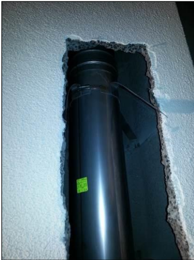
Abb. 13: Nach spätestens 3 Längenelemente a 1 m ist eine Montageschelle zur Fixierung im Schacht anzubringen.
