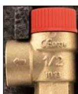
Unterziehe alle vorhandenen Sicherheitsventile der Heizungsanlage (zum Beispiel an Kessel, Pufferspeicher, Solaranlage oder Trinkwasser) einer Sichtprüfung. Die Abläufe der Ventile dürfen nicht tropfen. Tropft eines der Sicherheitsventile, öffne es kurz durch eine Vierteldrehung an der roten beziehungsweise blauen Kappe, um es auszuspülen. Schließt das Sicherheitsventil auch nach mehrmaligem Spülen nicht mehr dicht, muss es umgehend gereinigt oder ausgetauscht werden.
