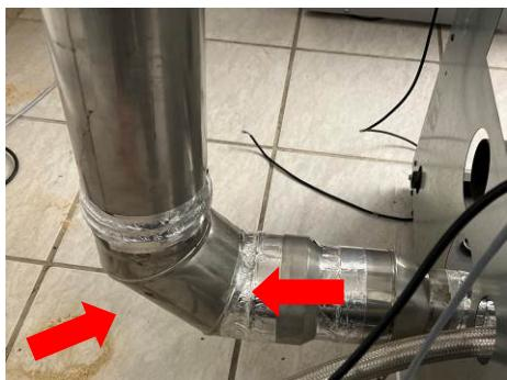
Öffne am Abgasrohr die Revisionsöffnungen, um das Abgasrohr vom Kessel in Richtung Schornstein zu reinigen. Wir empfehlen, diese Arbeiten durch den Schornsteinfeger durchführen zu lassen.
